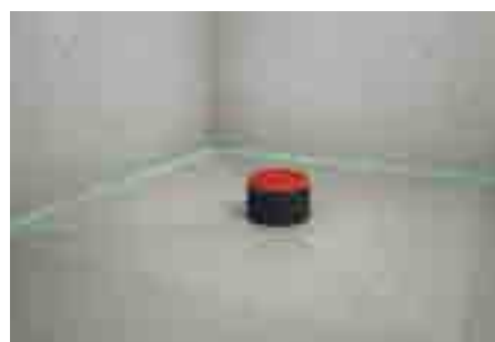
5. Užlieti betoną ir suformuoti min 2% grindų nuolydį trapo kryptimi.
