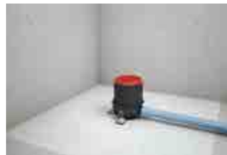
3. Tvirtinimo elementais pritvirtinti trapą prie grindų ir prijungti nuotekų vamzdį.
