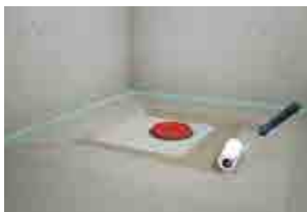
8. Užsandarinti trapo korpuso ir grindų dalis. Hidroizoliacinė medžiaga tepama ant betono pagrindo, uždedamas geotekstinės flanšas ir vėl užtepama hidroizoliacija.
