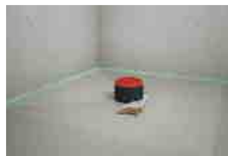
6. Kai betonai pilnai išdžius, pjūkleliu arba pjovimo disku nupjauti trapo paaukštinimo elementą iki reikiamo ilgio.
