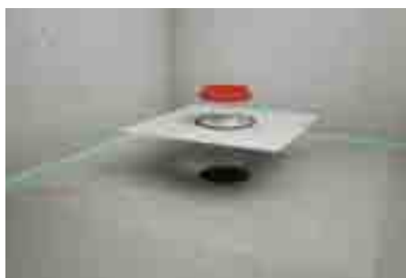
7. Prijungti hidroizoliacinį komplektą ir uždėti montavimo apsauginį dangtelį.
